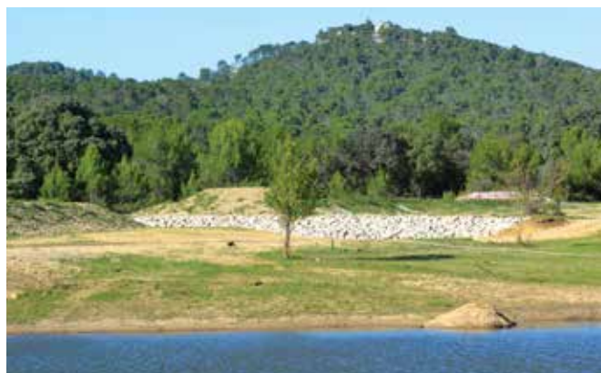
Deux déversoirs ont été créés au barrage du Jeantou cet été.
