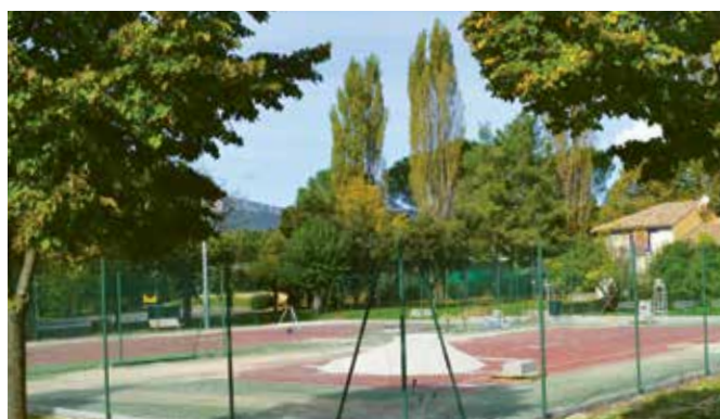
Réfection et rénovation des courts de tennis
