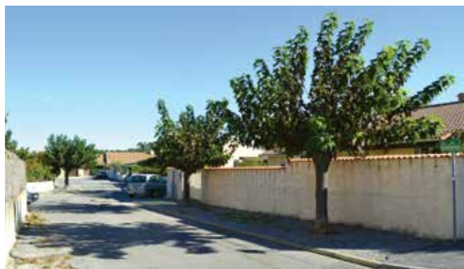
Réfection totale de la voirie et des trottoirs rue des Wisigoths
